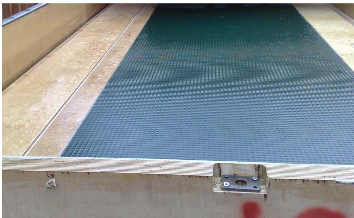
Esimerkki puisesta betonimuotista johon on liimattuna GIAN® kuviomatto
