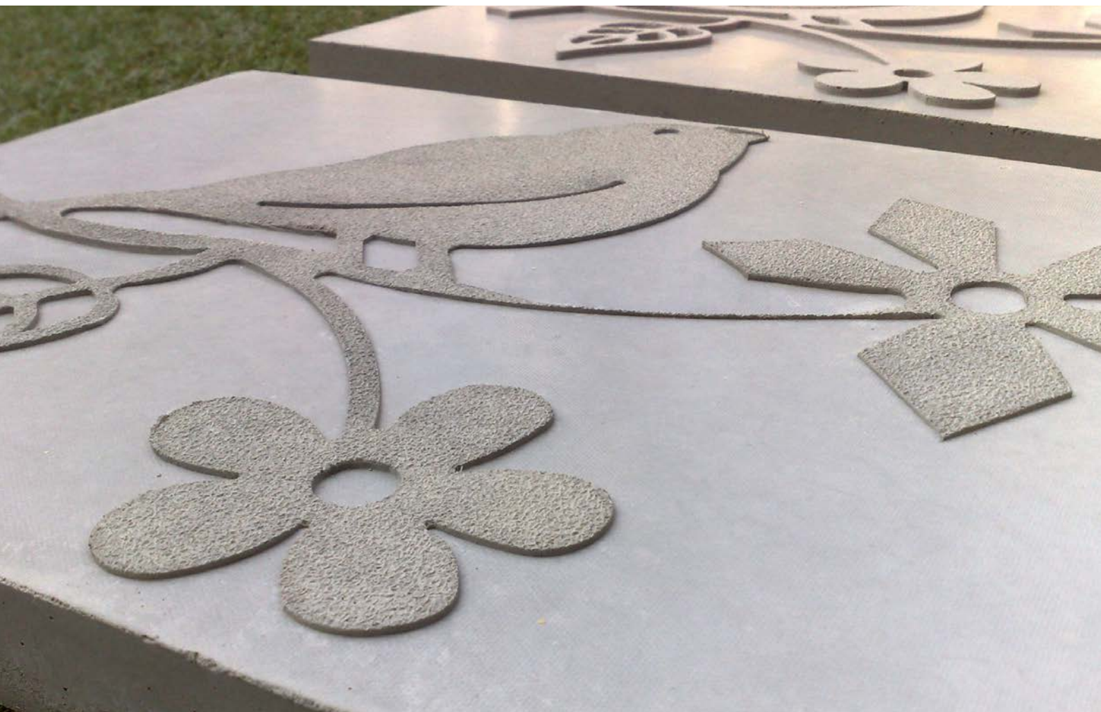
Tietokoneohjattu leikkaus GIAN® 100 (sileä) kuviomatossa, yhdessä GIAN® 2 hiekkapuhalletun kuvion kanssa.
