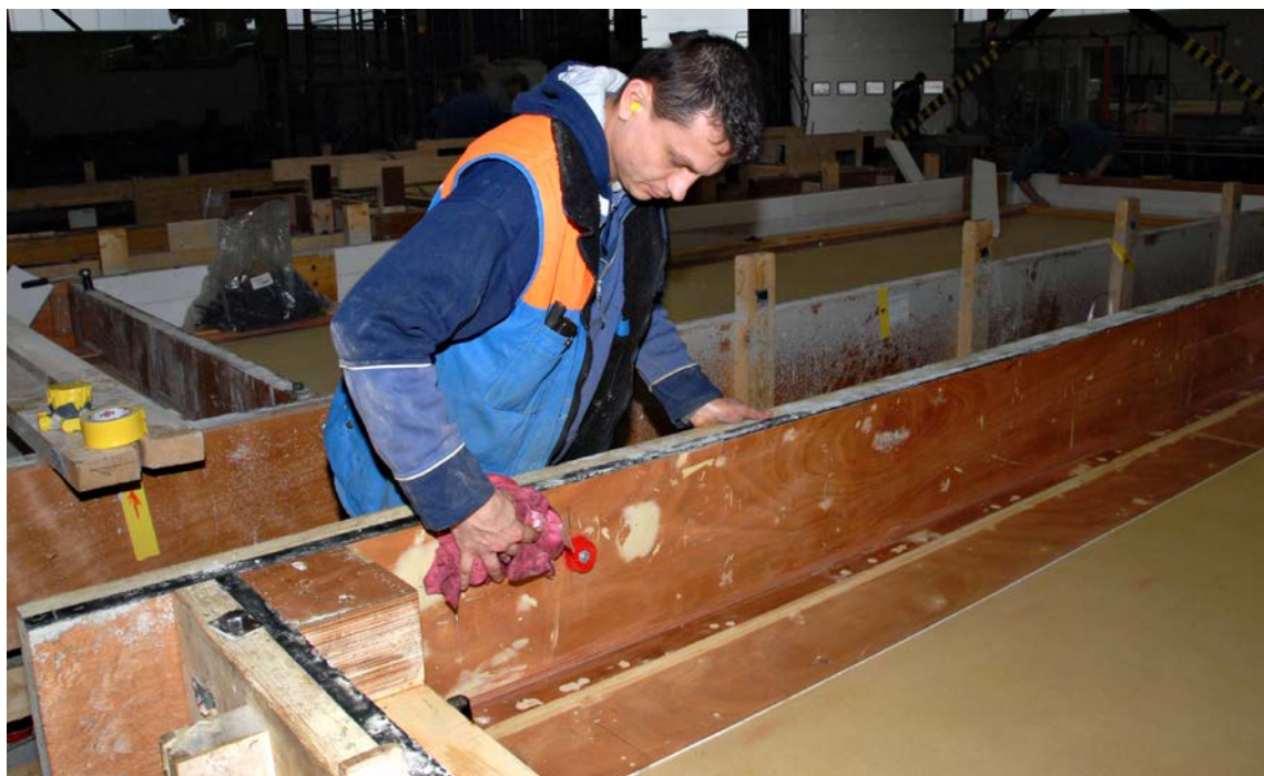
Betonimuotti puhdistetaan seuraavaa valua varten.
